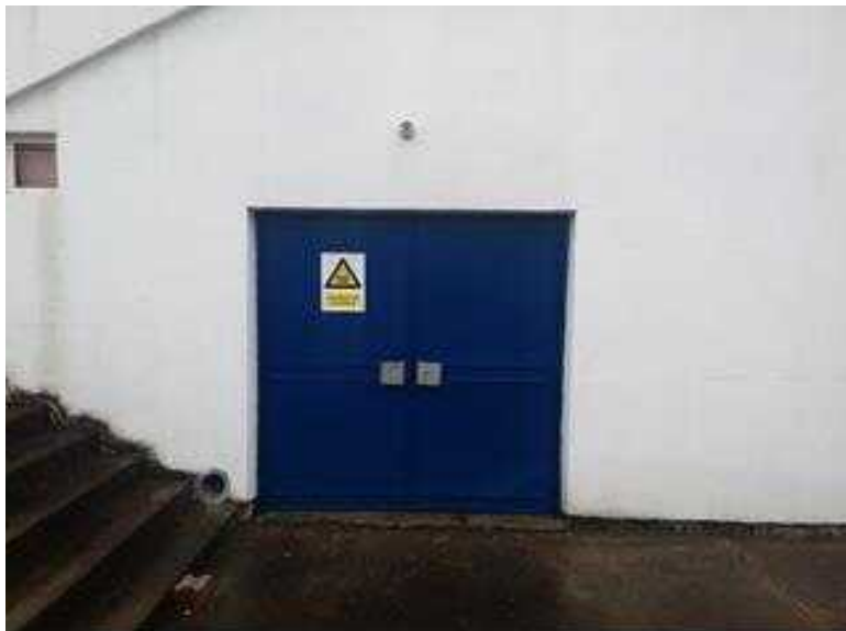
Slika 5.2 – Strojarnica s klornom stanicom
